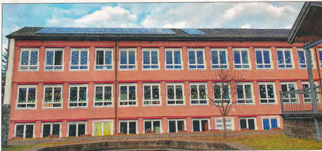
Die Klassenzimmer der Grundschule in Teisendorf werden in den kommenden Tagen mit Luftfiltergeräten ausgestattet – wie auch andere Einrichtungen. (Foto: Konnert)
